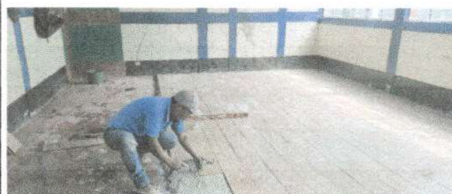
Foto 8: Sustrucción de piso de cemento líquido (Dirección y 2 módulos)
