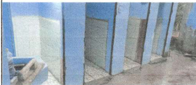
Foto 10: Foto 8: Mantenimiento a estructura (lijado, cambio de tubo, cepillado, sujeciones, aplicación de pintura) a las puertas del servicios sanitarios.
