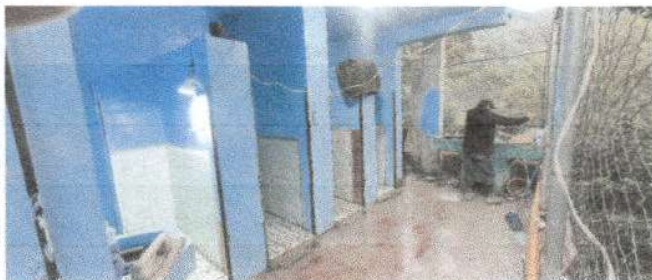
Foto 7: Sustrucción de piso líquido (por piso antideslizante en los baños)
